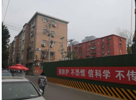
项目东侧 17 号住宅楼
